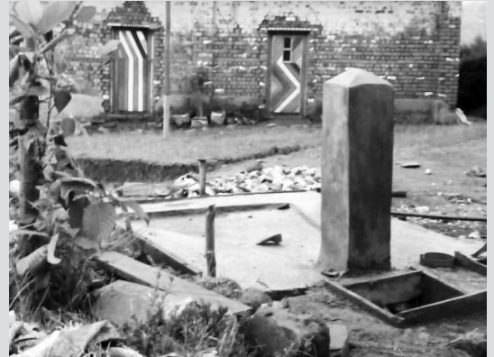
Der öffentliche Trinkwasserbrunnen im Dorf Kisanga kurz vor seiner Fertigstellung
